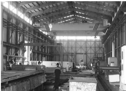
[그림 13] 사례 사업장 크레인 작업
